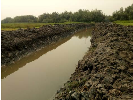
El canal central que se construyó para dejar entrar el agua en el sitio en restauración Djegbame, Ouidah (Benin).
